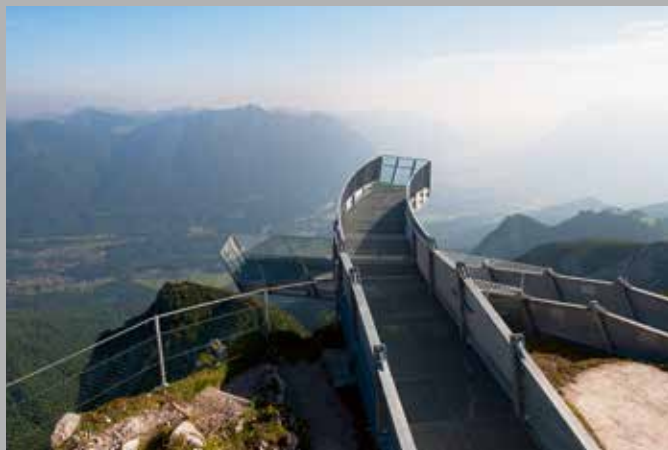
Aussichtsplattform mit verzinkten Pressrosten
