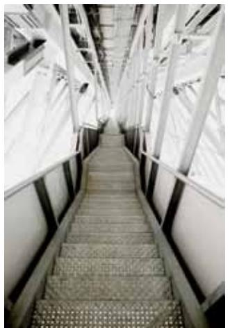
Modernste Schanzentechnik für die Große Olympiaschanze in Garmisch-Partenkirchen geplant und geliefert von Lichtgitter. Blechprofilroste unterschiedlicher Typen sorgen für sicheren Stand auf 314 Stufen und 17 Zwischenpodesten der Haupttreppen sowie auf den Medien- und Startstufen und der anlaufbegleitenden Treppe.
