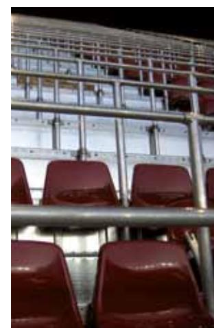
Bohrungen in den Belägen und Profilen dienen der Befestigung von Sitzen und Geländern. Dies beschleunigt die Montage erheblich. Den Zuschauern dienen die strapazierfähigen und rutschfesten Bleche als idealer Resonanzkörper.
