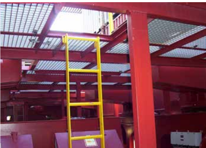
Unten: GFK-Gitterroste, montiert auf einem Schiff
