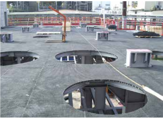
Oben: Leitfähige GFK-Gitterroste als Sonderanfertigung
